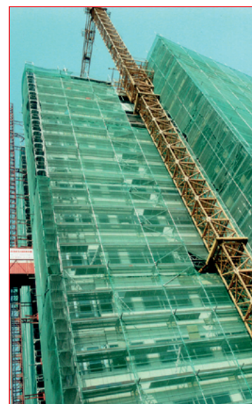
Budowa Apollo Rida - Warszawa
