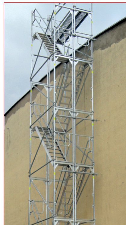
■ Przykład zmontowanej klatki dwuzabiegowej
