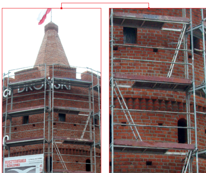
Renowacja fasady Baszty - Szczecin
