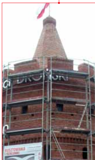
Renowacja fasady Baszty - Szczecin
