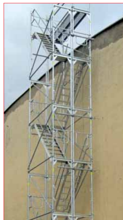
Przykład zmontowanej klatki dwuzabiegowej
