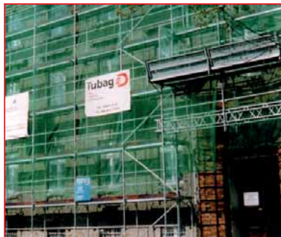
Przykład zastosowania dźwigara kratowego
