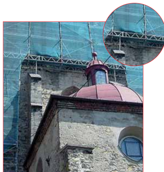
Renowacja fasady kościoła - Szydłowiec
