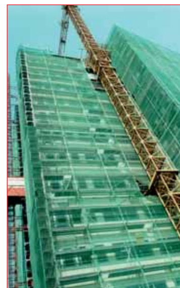
Budowa Apollo Rida - Warszawa
